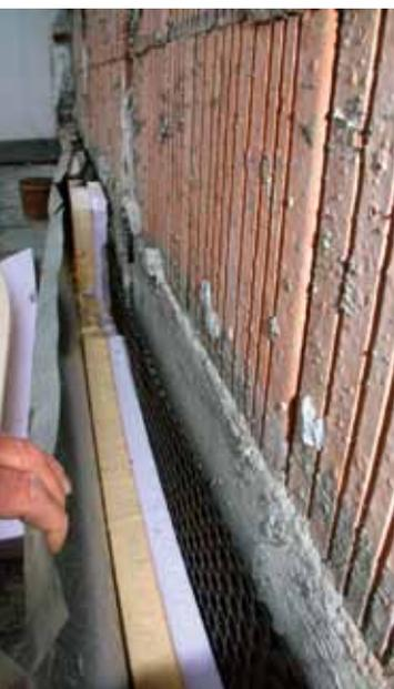
Seule une pose conforme à l'état de la technique empêche l'ascension et l'infiltration de l'air riche en radon du terrain.
